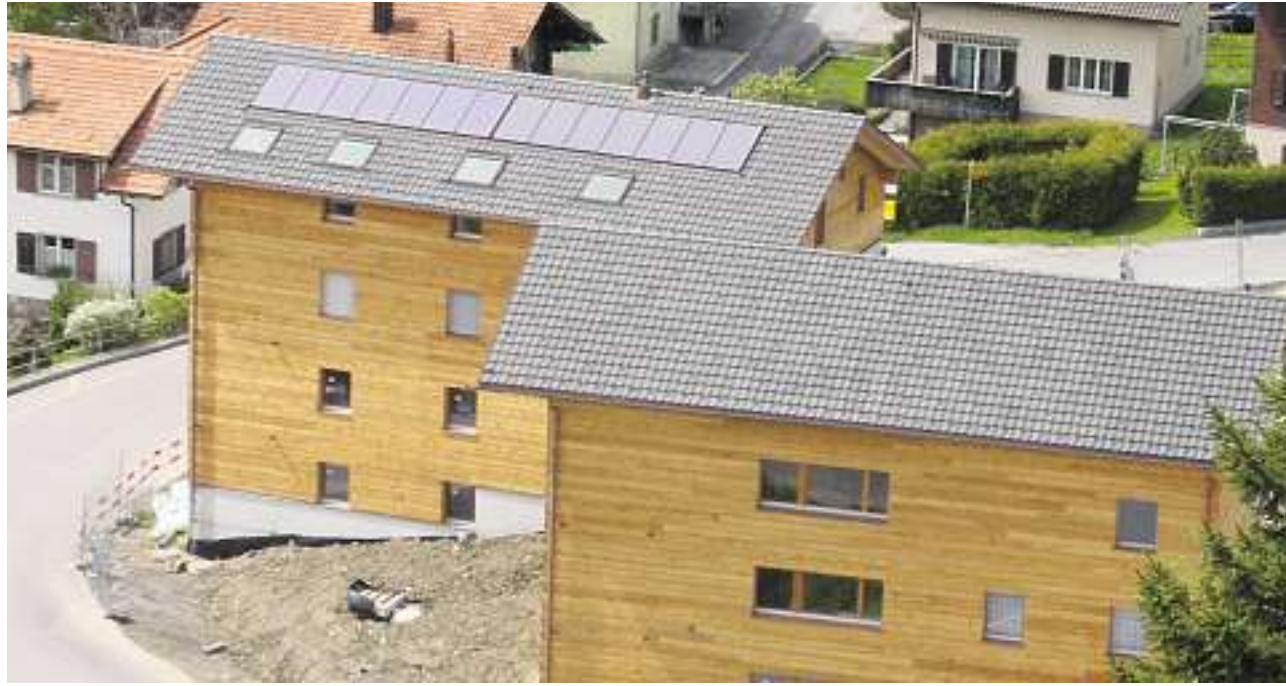
Sauber und wirkungsvoll: Thermische Solaranlage für zwei Mehrfamilienhäuser in Triesenberg
