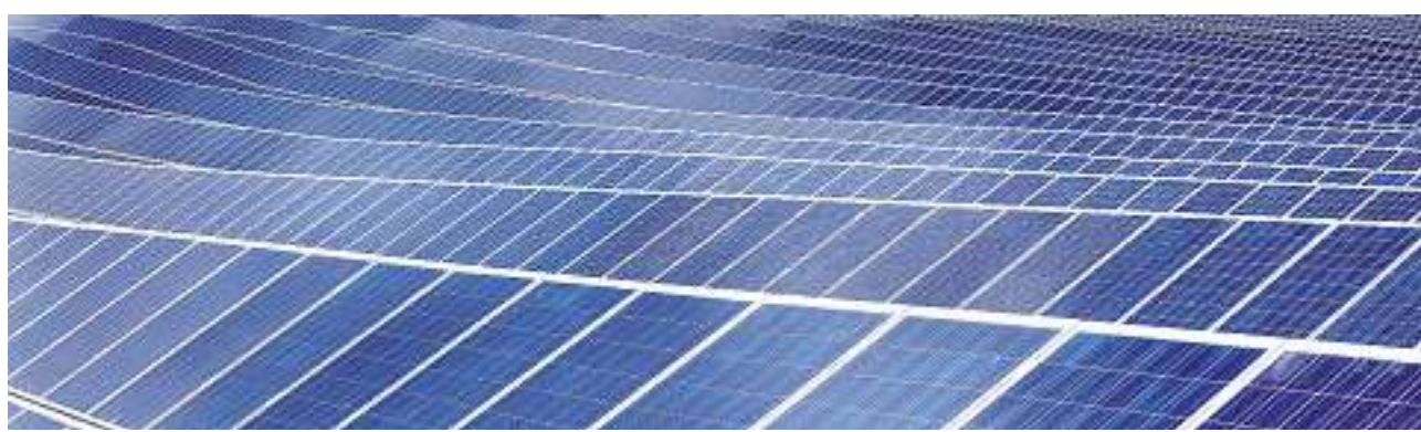
Hightech: Thermische Kollektoren und Fotovoltaikanlagen bündeln die Sonnenstrahlen.
